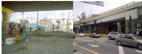
Figura 4. Parte baja puente vehicular (Toluca, México). Fuente: Archivo de investigación, 2014. Toma fotográfica propia.
