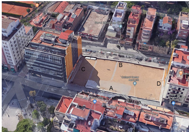
Figura 2. Vista cenital del solar que ocupará la antigua Clínica Quirón, tras la demolición del edificio. Fuente: Google Maps.
