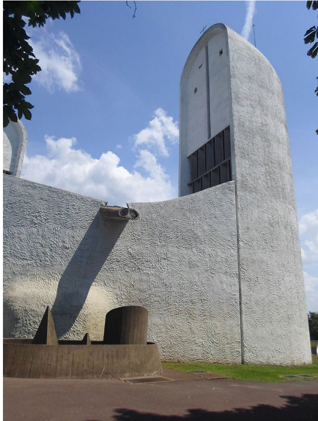
Figura 7. Torre de Ronchamp. Fuente: foto del autor.
