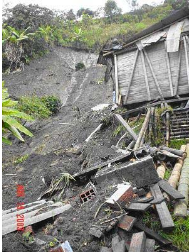
Figura 5. Las viviendas de ladera son construidas en áreas muy reducidas, factor que permite estimular su ampliación a partir de excavaciones en el pie de la ladera. Esta práctica es un factor detonante de deslizamientos.
