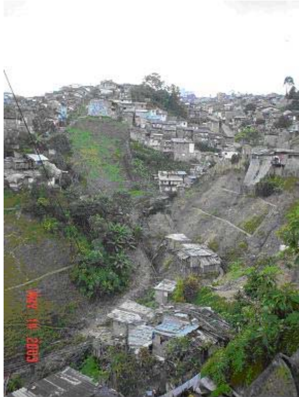
Figura 2. Viviendas en ladera de pendientes fuertes. Las edificaciones sobre áreas tratadas son los factores contribuyentes a la inestabilidad de la ladera.
